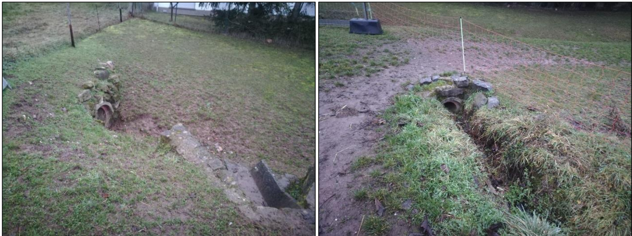
Abbildung 3: Blick auf das Ende der Verrohrung des Otzweiler Grabens (unterhalb der Römerstraße) (Foto links) und Verrohrung des Versickerungsgrabens im Zufahrtbereich auf die Weide unterhalb des Wirtschaftsweges (Foto rechts) (Fotos: GUTSCHKER-DONGUS 2021)
