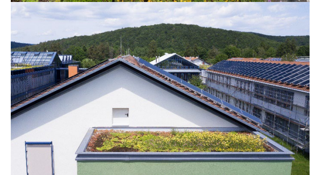
Dachbegrünung und PV am Umwelt-Campus © IfaS
